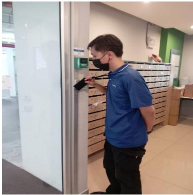
ภาพที่ 2.12 งานทดสอบการทำงานระบบเข้า-ออกอาคารโครงการ
