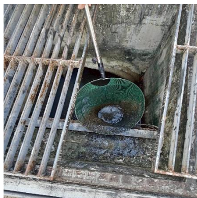
ภาพที่ 2.11 งานทำความสะอาดบ่อพักน้ำสุดท้ายภายในโครงการ และถนนการจราจร
